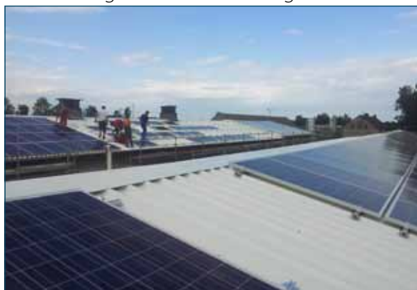
Montage einer Aufdachanlage in Marzahnna
