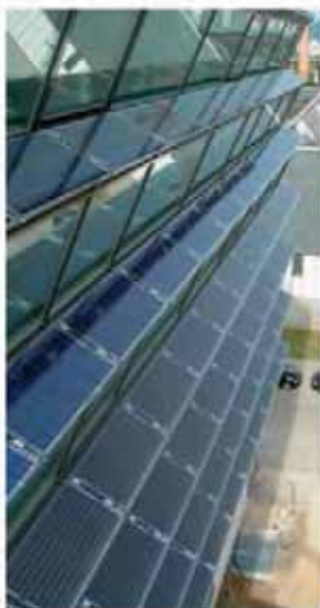
ENERGYbase, Wien, Österreich, 24 kW p
